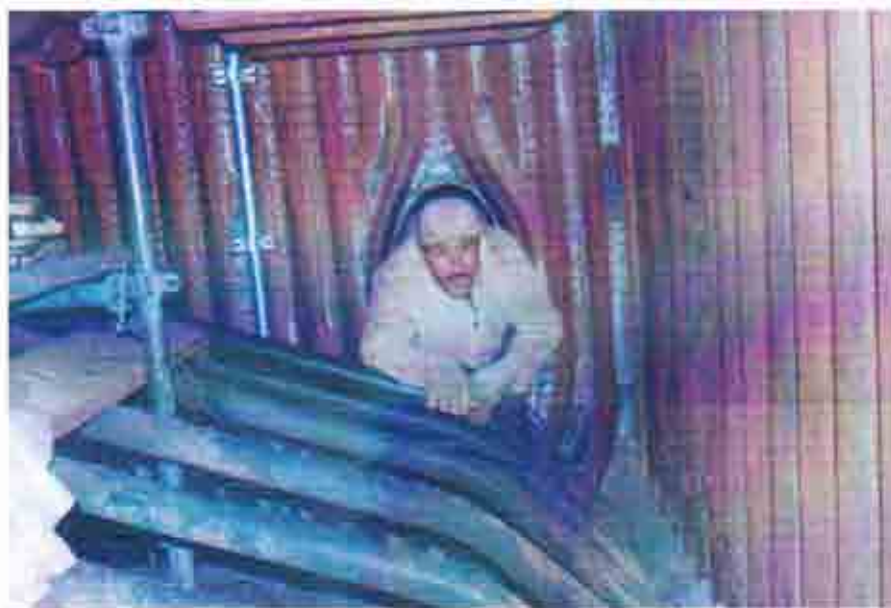
Niveau inférieur de la chaudière
