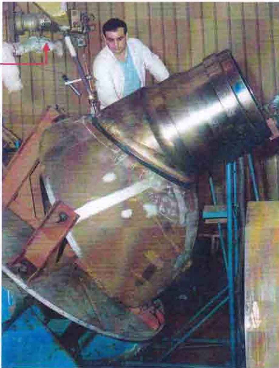
Raboutage de piquage sur un fond hémisphérique
