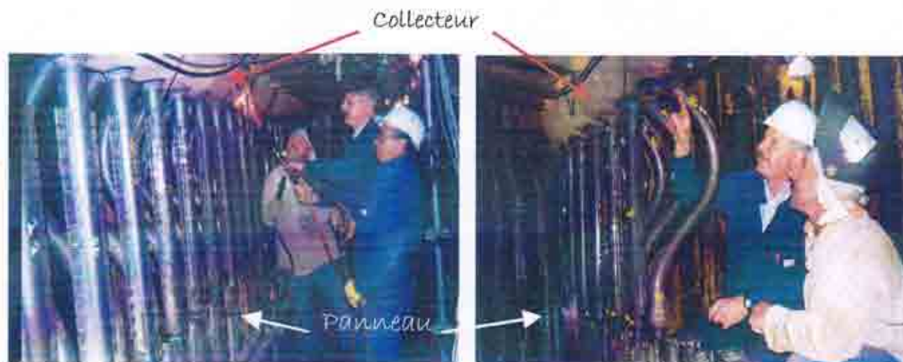
Soudure d'une manchette sur collecteur et sur panneau
